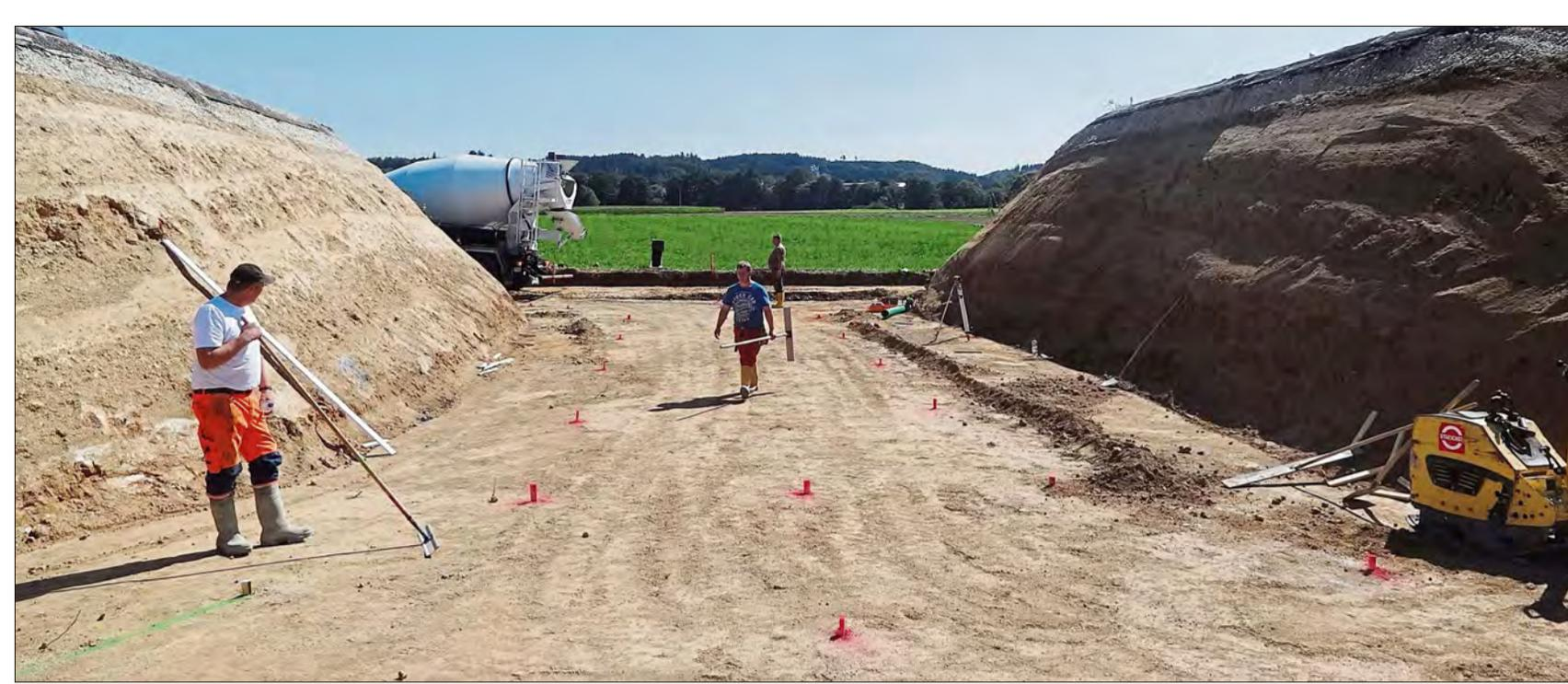
Die 17 Meter breite Fahrbahn der Bundesstraße B20 ist an der Stelle, wo die Fahrradunterführung gebaut werden soll, schon komplett abgetragen. (Foto: gh)
