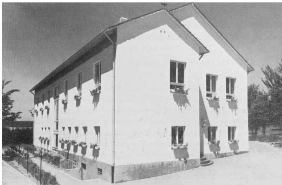
Das im Garten hinter der Landwirtschaftsstelle stehende Gebäude (früher Isolierstation des Krankenhauses) wurde 1950 zur Haushaltungsschule umgebaut.
